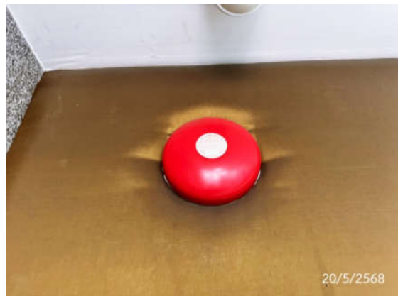
กริ่งสัญญาณเตือนภัย (Fire Alarm Bell)
